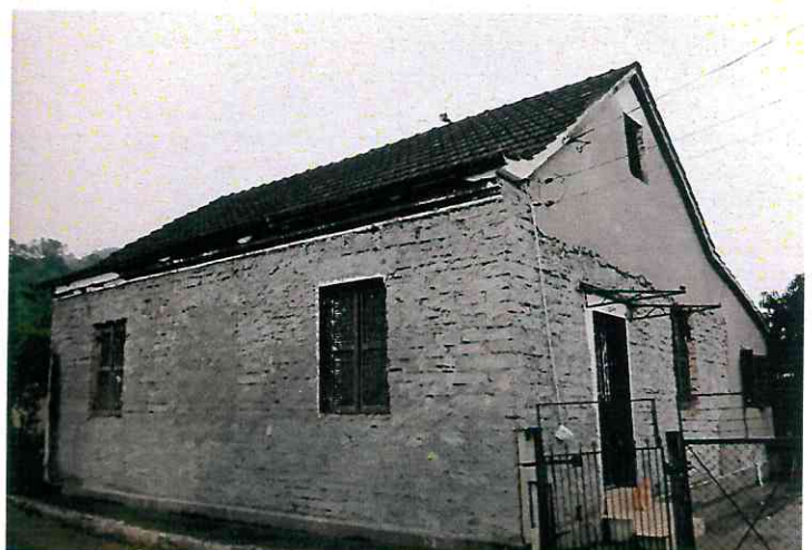
Reforma no imóvel realizada em 2010. Reboco, portas e janelas. A estrutura foi mantida. Fonte: Acervo pessoal de Ireni Juraci Dreher.
