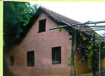
Em 1998, já com telhado substituído; Em 2008, reformada e com pintura nova. Fonte: Acervo pessoal de Clarise Elisa Moeller
