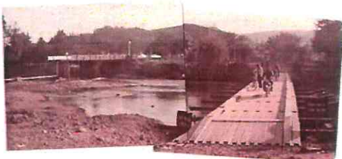
Ponte construída pelos militares em 1982.
