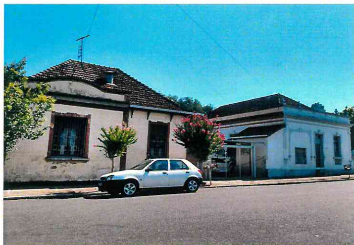
Foto atual da fachada das casas (2022). Fonte: Acervo pessoal de Camila Brum.
