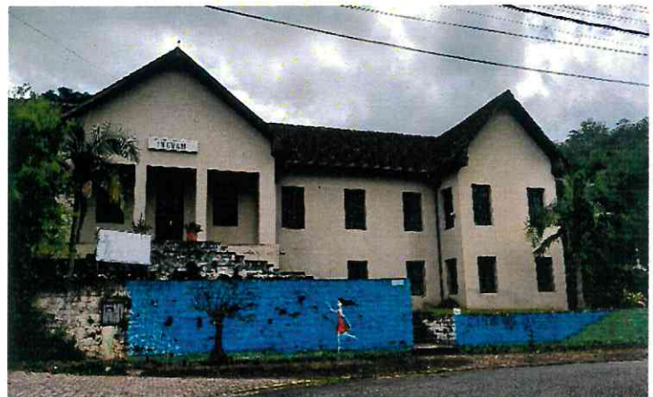
Fachada atual (2021). Fonte: Acervo pessoal de Kennedy Felipe Behling Azevedo.
