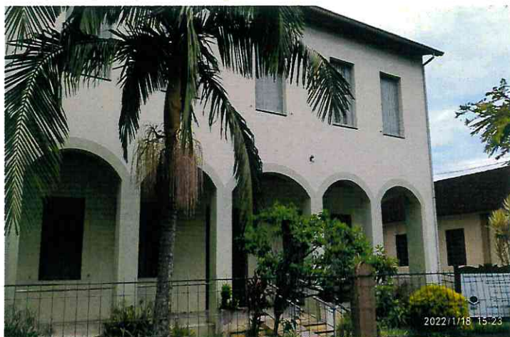
Fachada da Paróquia Evangélica do Município de Três Coroas (2022). Fonte: Acervo pessoal de Kennedy Felipe Behling Azevedo.
