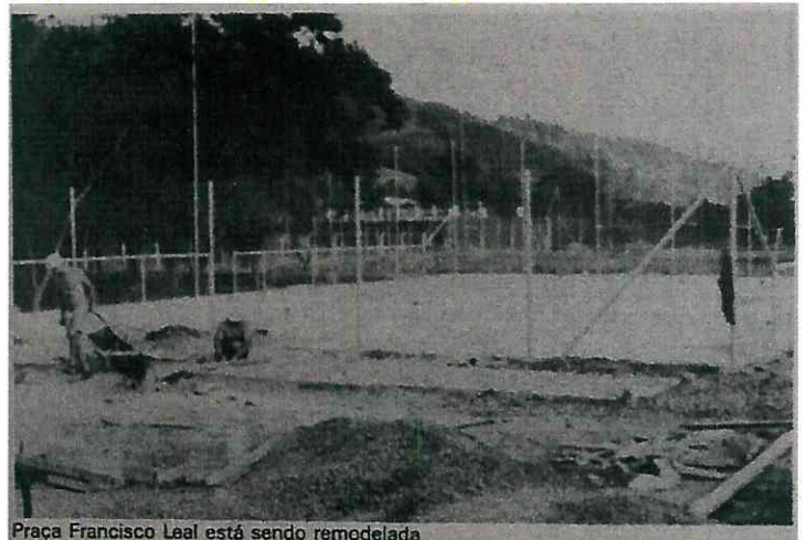
Praça Francisco Leal está sendo remodelada
