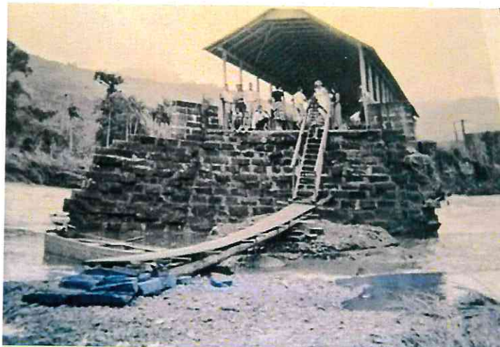
Foto da ponte, após a enchente de 1956.
