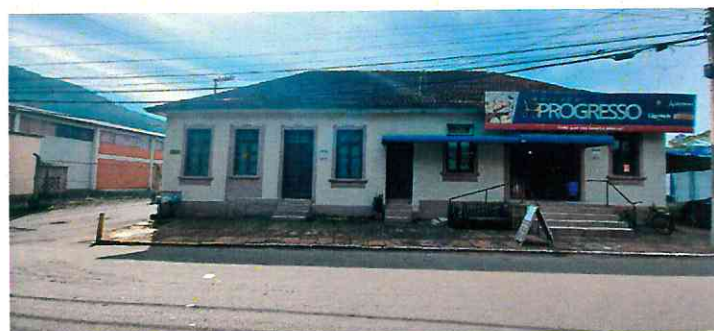
Foto externa da construção (2022).
