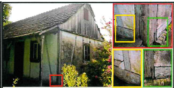
Vigamento em madeira e detalhes estruturais de casa em técnica enxaimel.
