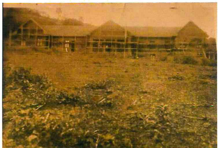
Construção do prédio (década de 1930). Fonte: Acervo pessoal de Floriano Grin (Facebook: Três Coroas ontem e sempre).
