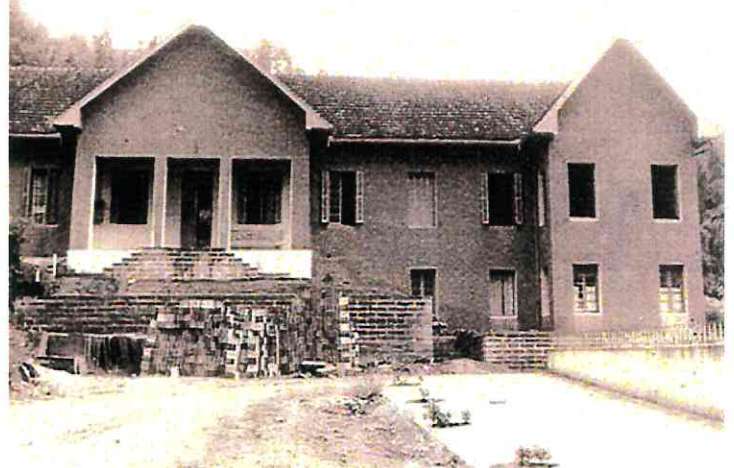
Construção do prédio (aprox. 1934).
