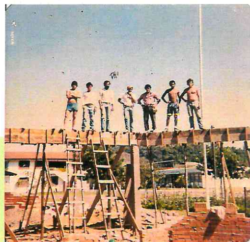
O construtor Ramão Rodrigues edificou o quiosque juntamente com outros pedreiros de fora da cidade (2011).
